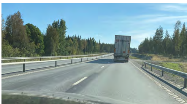
Bild 2. E4 södergående fil i höjd med Dalkarlså. Här närmar man sig platsen där två filer snart blir en. Bakom kurvan ligger en rastficka. Sikten framåt skymms vid omkörning effektivt av framförvarande lastbil. Detta i kombination med svårigheten eller omöjligheten att från en långtradare i rastfickan se alla avsnitt av vägen bakom sig, blir en "giftig cocktail" som bäddar för denna typ av krascher.
