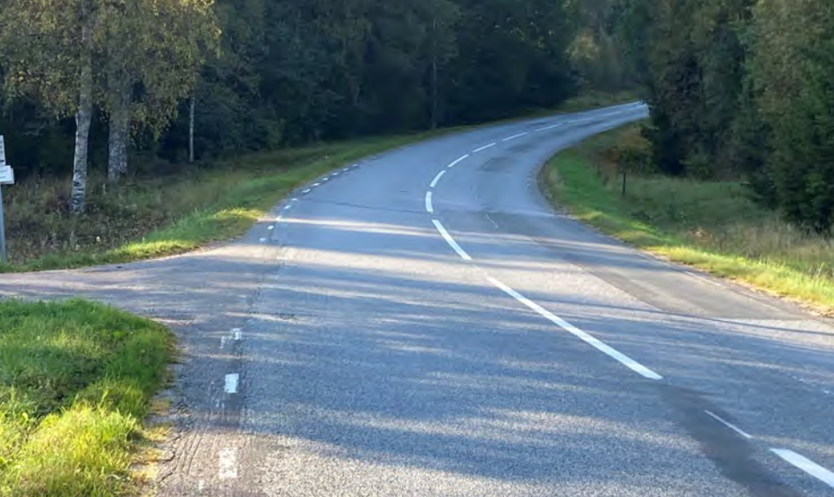
Bild 4. Bild tagen från platsen där föregående räckesbild tagits. Nedförsbacke och kurva strax före bron bäddar för misstag i halt väglag.
