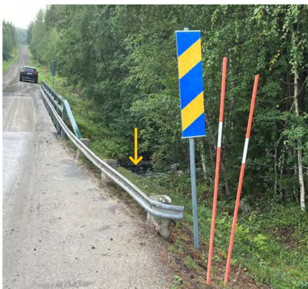
Bild 6. Här är det lätt att man antingen spetsas på räcket och/eller kör vidare ner i vattendraget (som räcket skulle skydda emot).
