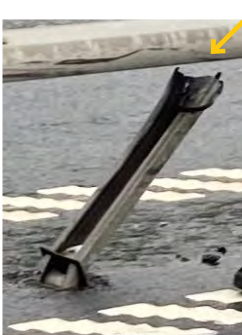
Bild 8. Stolpen i mitträcket där mc-föraren kraschade. Fordonsdelar fanns kvar på platsen som var belägen mitt för rastfickan. Ingen av motorcyklisterna kolliderade med lastbilen.
