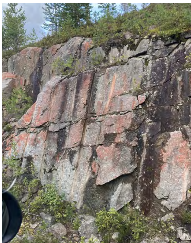
Bild 2. Här syns att man nyligen sprängt bort en del berg som var extremt nära vägbanan. Detta är ett steg i rätt riktning, men det är ju uppenbart risk för mycket allvarliga personsador vid en kollision med denna oskyddade bergvägg vid väg 352, mellan Fredrika och Örnsköldsvik.
