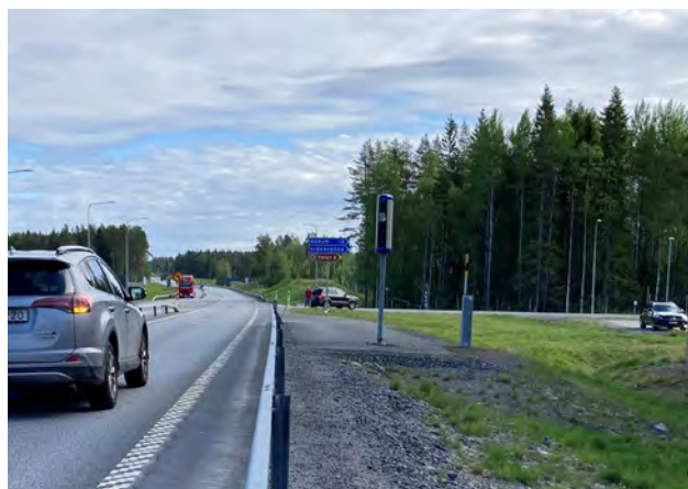
Bild 13. Här närmar man sig korsningen mot Norum/Djäkneboda. Hastighetsgränsen är strax före sänkt till 80 km/tim och fartkamera är uppsatt. Avfarten är tvär med en 90-graderssväng som är särskilt utmanande vintertid, då halkan utgör en komplicerande faktor, både för den som ska svänga och för dem som ska bromsa på E4:an. Som syns på bilden finns gott om plats att göra en mjuk avfart, då hastighets-sänkningen skulle bli lättare att hantera. Ett bra sådant exempel finns vid E4:ans avfart mot Täfteå/Täfteböle, se bild 15.
