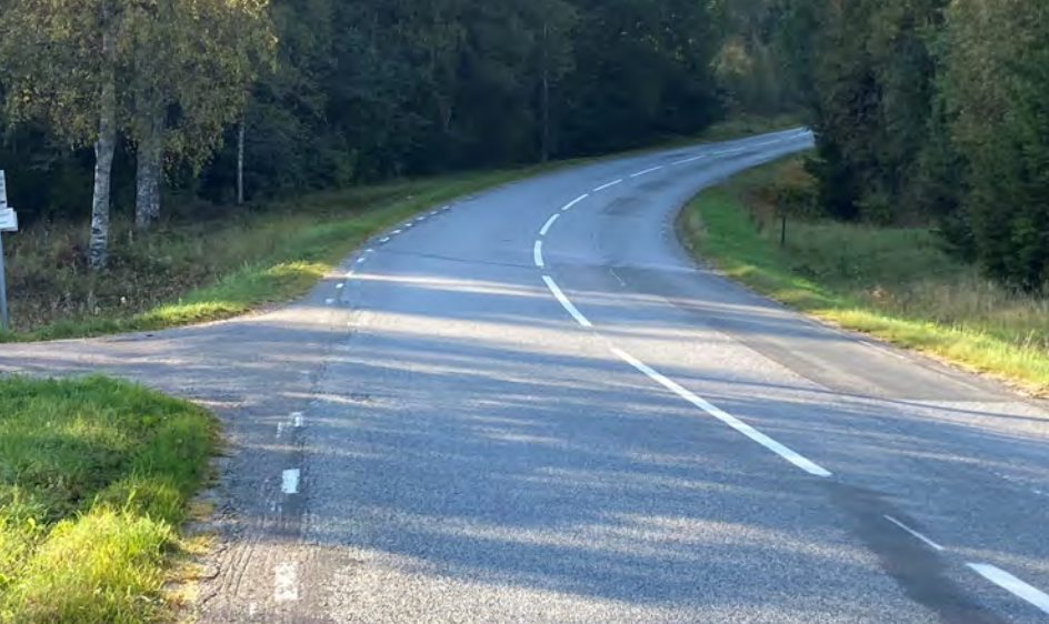
Bild 4. Bild tagen från platsen där föregående räckesbild tagits. Nedförsbacke och kurva strax före bron bäddar för misstag i halt väglag.
