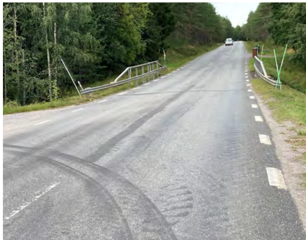
Bild 1. Typisk bro, i detta fall på en sex meter bred väg med hastighetsgräns 70 kilometer i timmen, som är högtrafikerad sommartid. Väg AC 522, Stöcksjö, Umeå.
