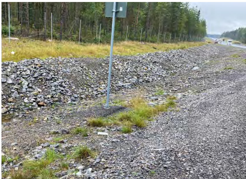
Bild 1. Bilden visar ytbeläggningen på avkörningszonen vid sidan av vägen på den 2023 renoverade sträckan av E4 söder om Bygdeå. De flera kilotunga stenarna riskerar att kastas in i fordon som kör i diket och välter. Hastighetsgränsen är 110 km/tim på platsen.
