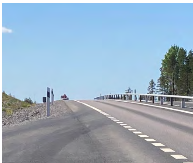
Bild 11. På andra sidan backkrönet som är ett hundratal meter bort, dyker en personbil upp. Observera att varselljusen inte syns. 110 km/tim innebär 3–5 sekunder kvar till rastfickan.
