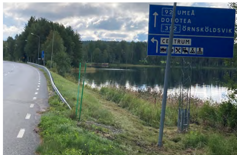
Bild 10. Fredrika, 500 meter från platsen för tidigare dödskrasch (bild 8 och 9) ser det ut så här i riktning mot Umeå. Att halka av vägen och fortsätta ner i vattnet verkar inte alltför svårt. Det är aningslöst av ansvariga att inte åtgärda detta, när man i närheten, med nästan identisk geografi, haft flera allvarliga olyckor.
