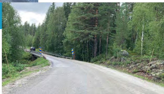
Bild 5. Hos många mindre vägar inåt landet ser överfarterna över vattendrag ut som på dessa bilder från Lv 592, Vargträsk mot Fredrika. Bilden visar en nerförsbacke och kurva just före bron över vattendraget, således en plats där det kan förväntas vara extra halt när kylan kommer under vintertid.
