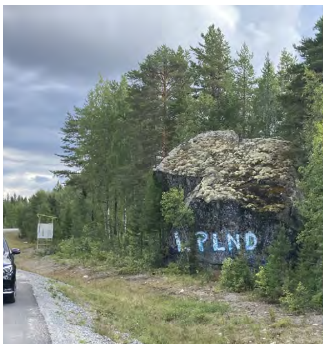
Bild 2. Här syns att man nyligen sprängt bort en del berg som var extremt nära vägbanan. Detta är ett steg i rätt riktning, men det är ju uppenbart risk för mycket allvarliga personsador vid en kollision med denna oskyddade bergvägg vid väg 352, mellan Fredrika och Örnsköldsvik.
